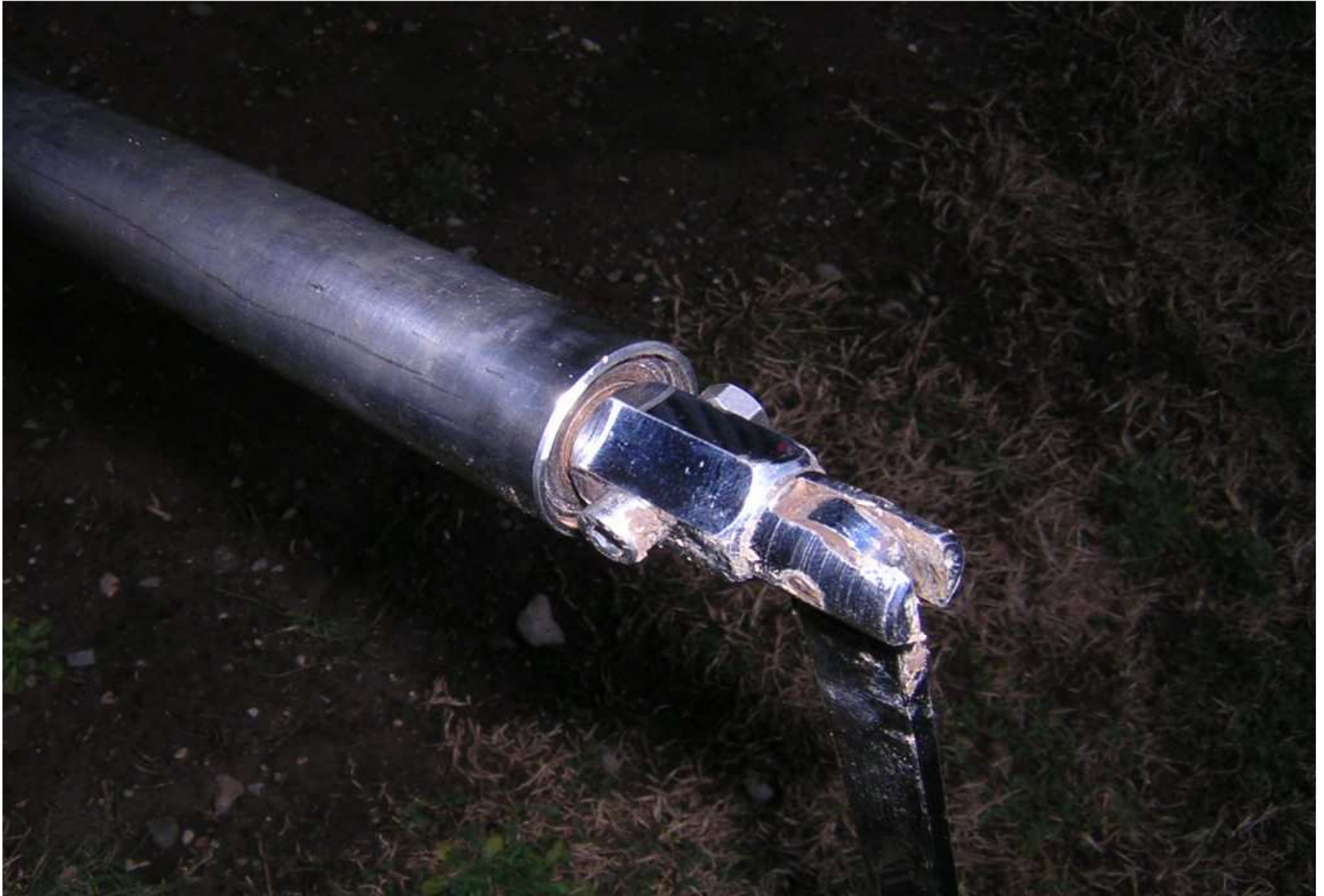
Manivelle et axe de volets roulants
